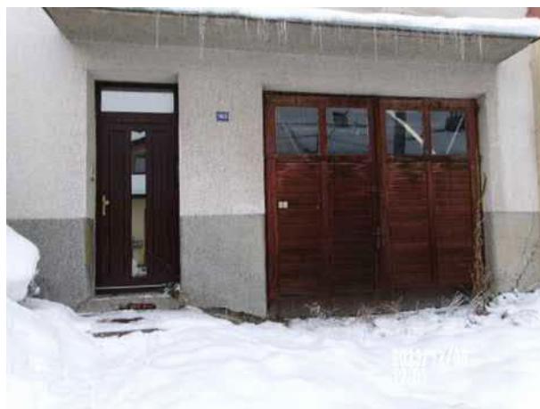
vchod z ulice
