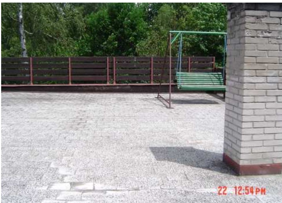
Pochůzná terasa nad předním traktem stavby č. 42, Oslnovice
