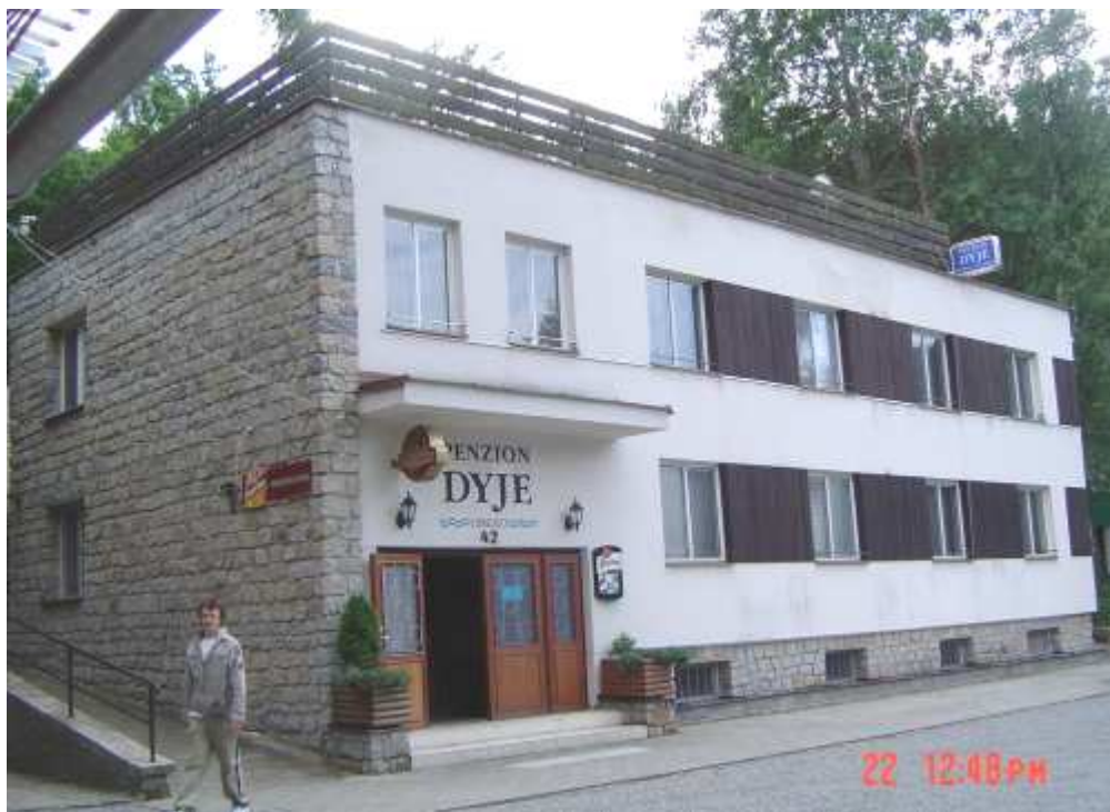
objekt č. 42 Oslnovice
