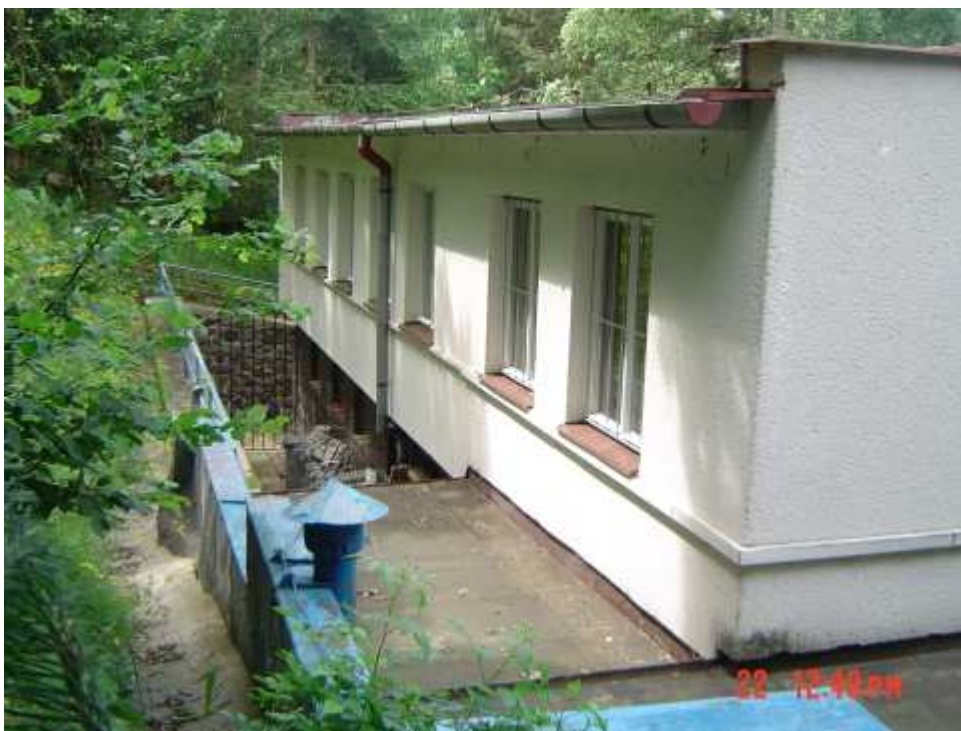
Zadní průčelí objektu – za stavbou svažité terén
